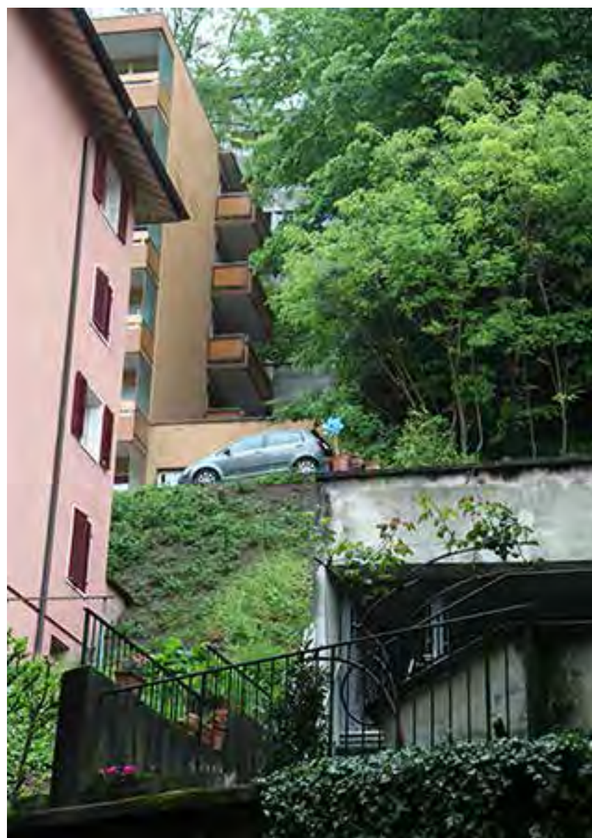
Fig. 18 Limites physiques : Ruptures topographiques importantes au Vallon.
