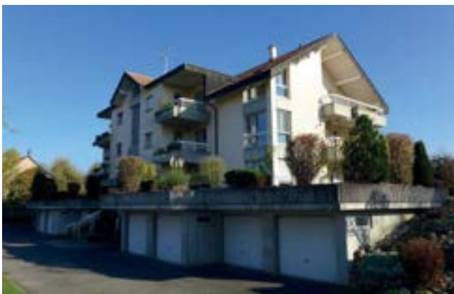
Stationnement TIM à proximité
