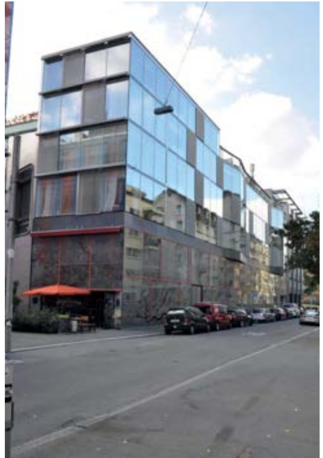
Construction de haut standard
