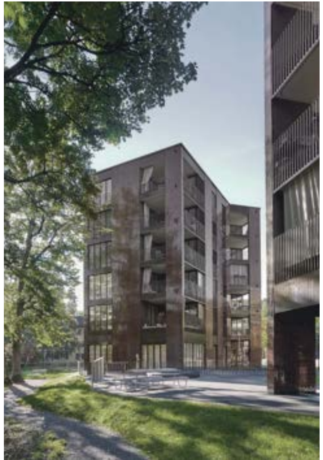
Lotissements en immeubles de petite taille
