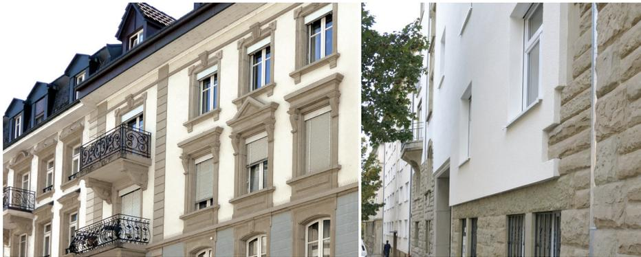
Abb. 45 und 46. Rechts, die Auswirkungen einer unüberlegten Aussenwärmendämmung auf die architektonischen Charakteristiken des Gebäudes. Links, ein vergleichbares unsaniertes Gebäude mit den architektonischen Merkmalen der Bauperiode.
