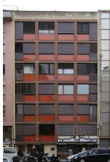
Der erhebliche Mehrverbrauch des Gebäudes könnte auch auf die fehlende Wärmespeicherfähigkeit der Gebäudehülle zurückgeführt werden (leichte, stark verglaste Fassade).
