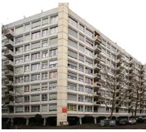
**Fallstudie 08.** Die Brüstung besteht aus einem monolithischen Betonfertigteilelement ohne weitere Bauteilschichten bis auf einen Innenanstrich. Die Messung wurde in einem Brüstungsbereich mit ausgeschaltetem Heizkörper durchgeführt. Mögliche Hypothesen zur Erklärung der Abweichungen sind:
