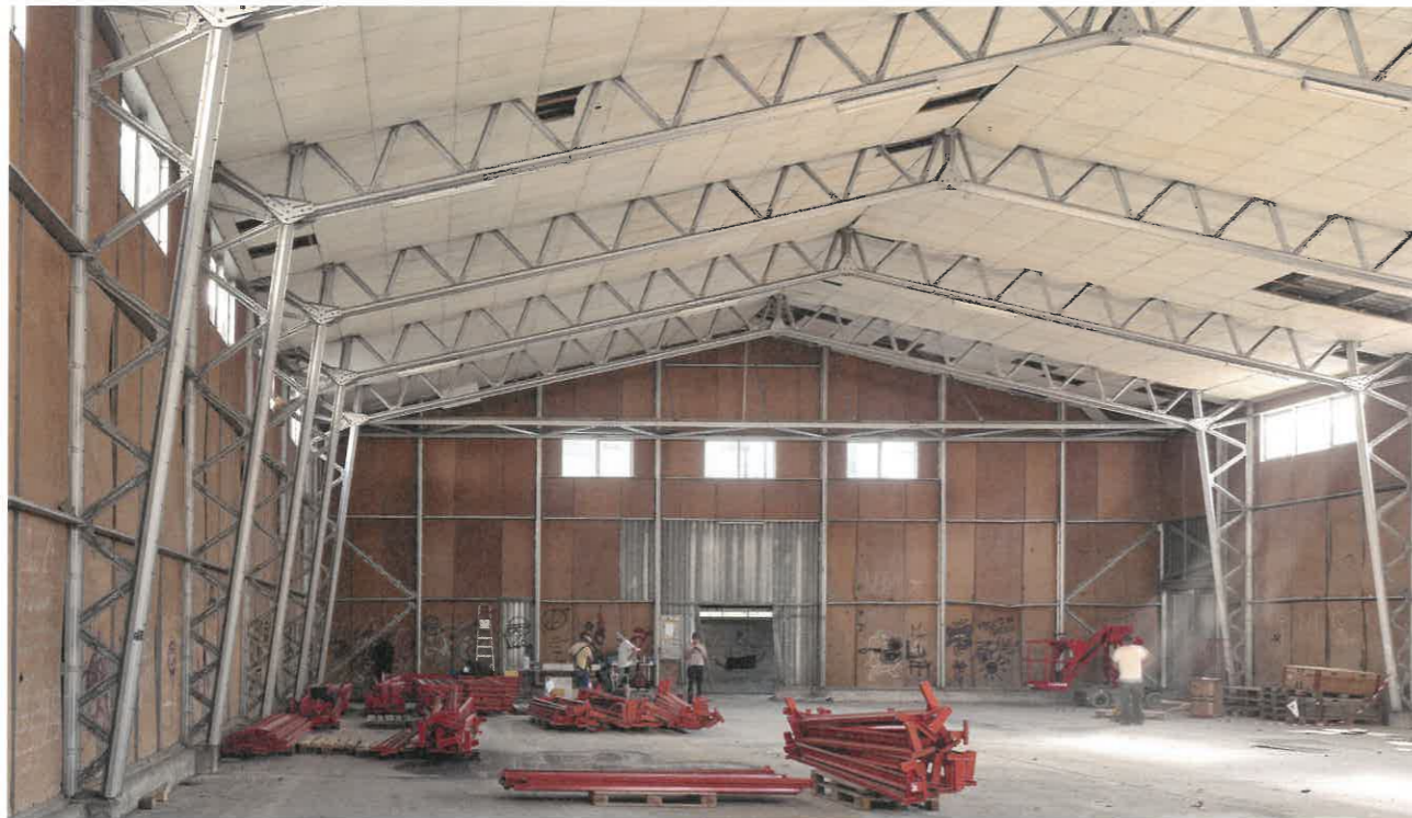
Démontage de la halle POLYNORM à Fribourg.
