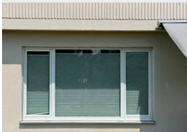
Fensterersatz mit Dreifachisolierverglasung
