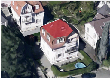
Südöstliche und südwestliche Dachflächen mit Photovoltaikziegeln
