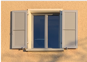
Rekonstruktion der Fensterleibungen mit gedämmten Fertigteilenelementen
