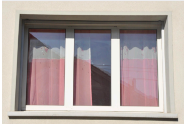
Beispiel einer neuen Fenstereinfassung mit Fertigteilenelementen
