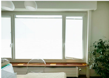
Dämmung der Rolladenkästen und Reduktion der Wärmebrücken
