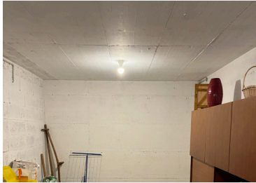
Zu dämmende Kellerdecke
