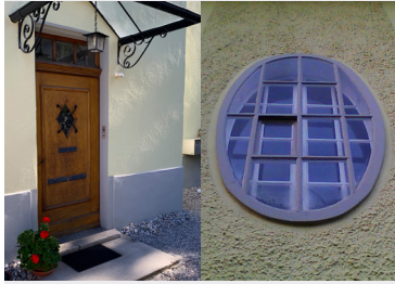
Porte d'entrée en bois d'origine et double fenêtre en bois, simple vitrage à préserver
