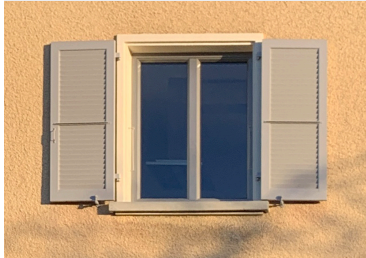
Embrasures et tablettes à isoler et à reconstruire en ciment
