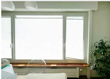
Isolation des caissons de store et coupure du pont thermique au plafond
