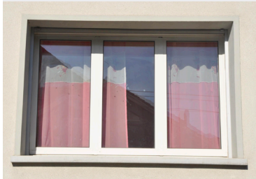
Ex. de reconstitution d'un encadrement en ciment lors de l'isolation
