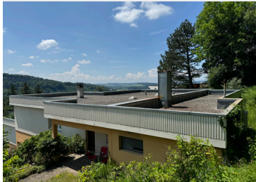
Toiture de la dernière maison, possibilité d'installer des panneaux photovoltaïques
