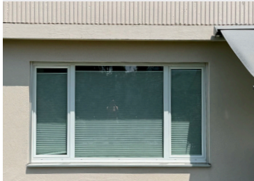
Remplacement des fenêtres par des fenêtres triple vitrage
