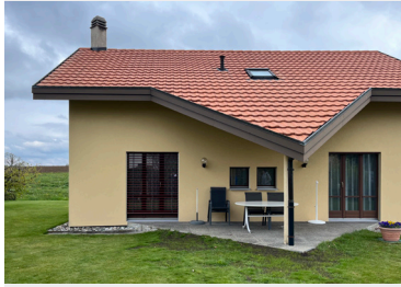
Pan de toiture sud avec terrasse
