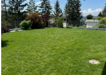
Terrasse-jardin sur la toiture de la maison voisine, isolation à refaire dans le futur
