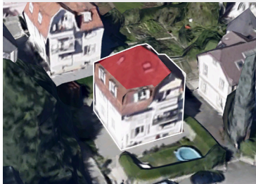
Pans sud-est et sud-ouest recouvert de tuiles photovoltaïques
