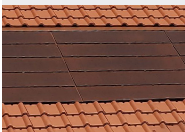
Pose de panneaux photovoltaïques en bande
