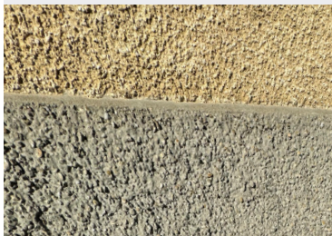
Crépi minéral épais ouvert à la diffusion de vapeur avec traitement différencié au niveau du socle
