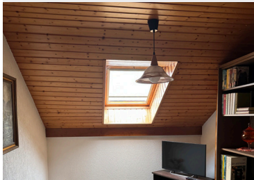
Toiture à valoriser afin de gagner en volume au niveau de l'étage
