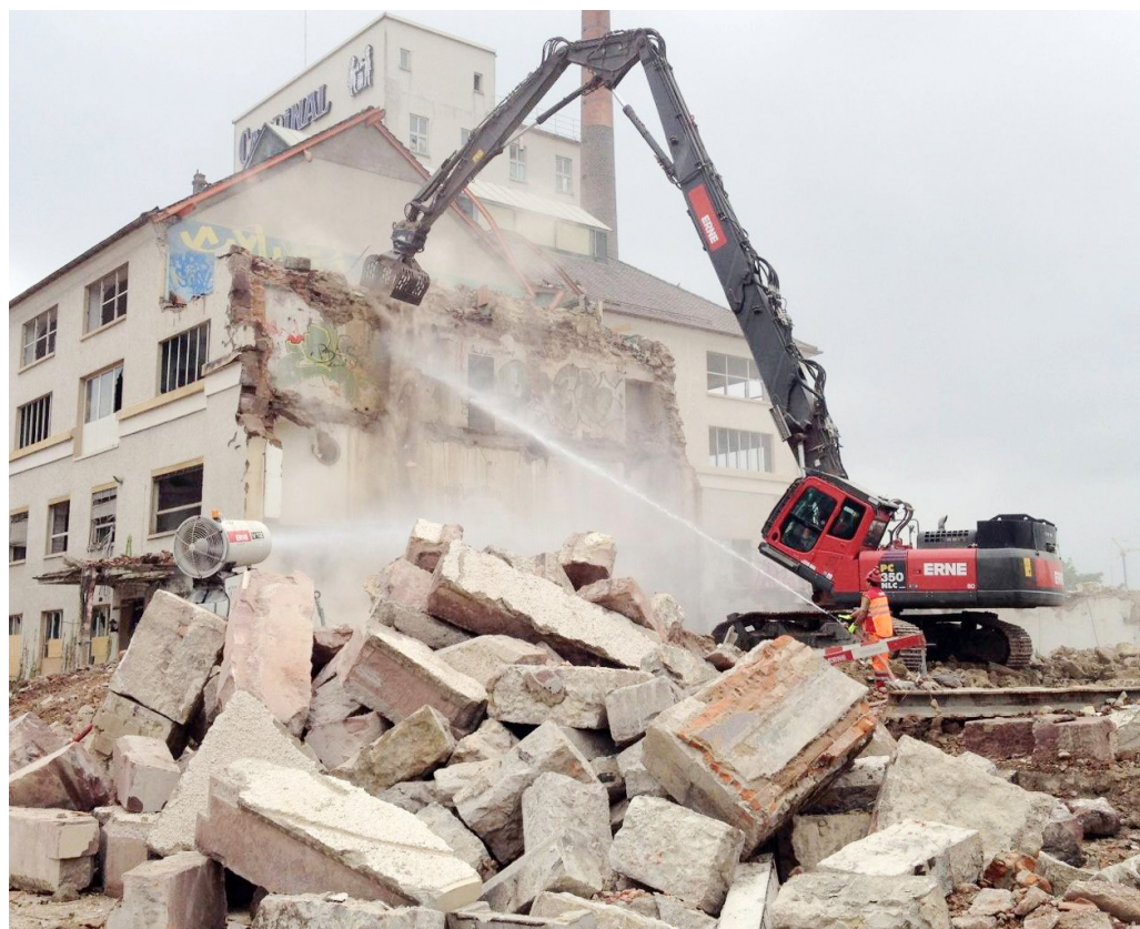
Destruction des bâtiments sur le site de blueFACTORY. © DR
