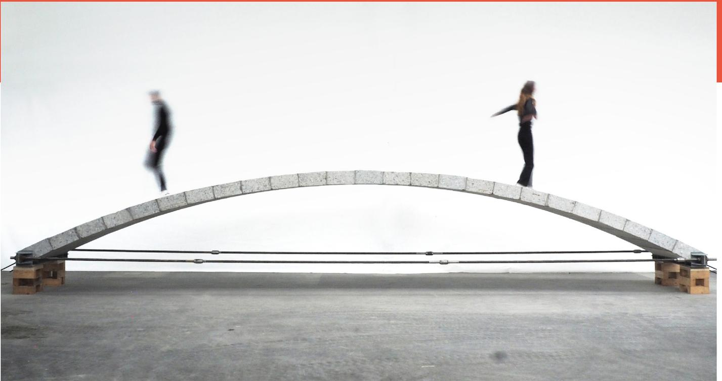
Fussgängerbrücke aus Stahlbetonblöcken
